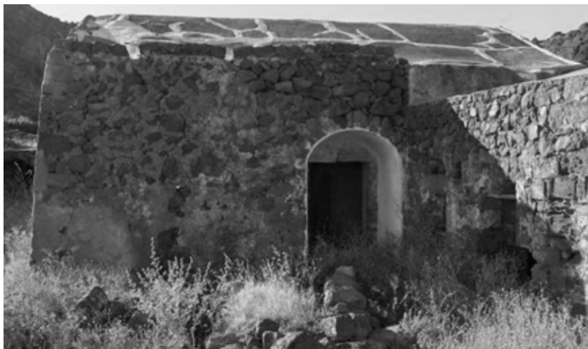
Fig. 5: Dammuso con volte a botte e tetto a capanna, con pianta a croce, in località Monastero. L'impianto planimetrico, atipico per i dammusi, fa presumere che questo fosse il refettorio del Gran Monastero di S. Giovanni
